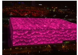
Water Cube, Nationales Schwimmzentrum, Peking, China
